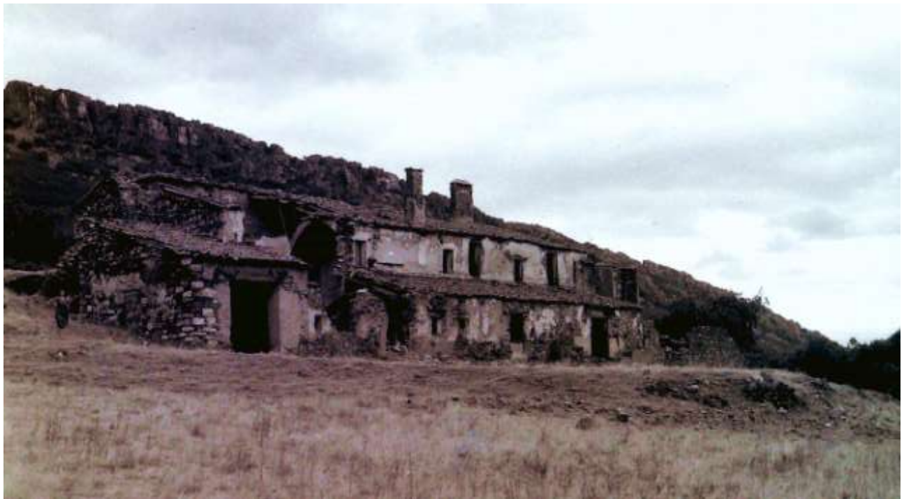
Fachada sur (Fotografía tomada en agosto de 1976)
